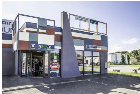
Façade de l'immeuble
