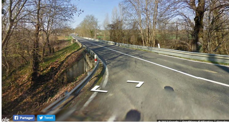
Miramont d'Astarac RN 21 : Travaux sur le pont de l'Arbiou
