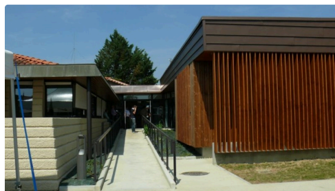
L'immeuble : à gauche l'ancien réalisé par l'architecte Edmond Lay et à droite l'extension réalisée par IAM architectes.
