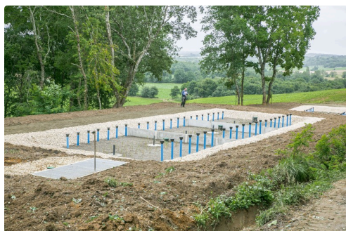
La station d'assainissement qui vient d'être achevée
