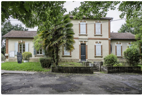
Bâtiment mairie + école + logement communal
