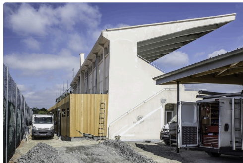
En jaune l'extension des vestiaires (état le 27 juillet)
