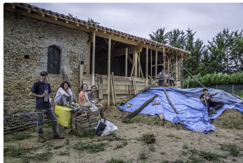
Reconstruction du mur de terre
