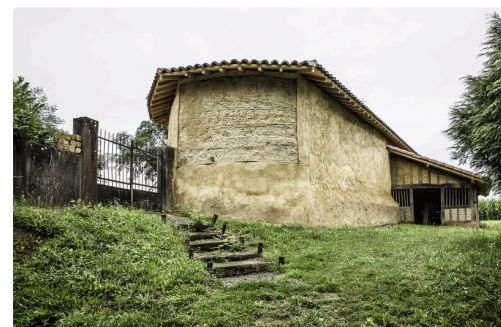
La chapelle vue de la route
