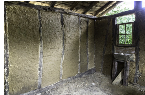
3 Intérieur de la maison du four 1bis 070817.jpg
