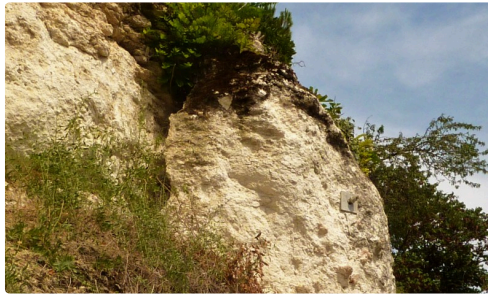
La partie qui menaçait de se détacher a été fixée par des pointes sur la partie solide.
