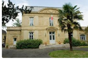
Journées du patrimoine : La sous-préfecture ouvre ses portes
