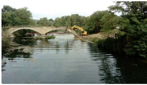
La pelle pousse l'arche en suspens
