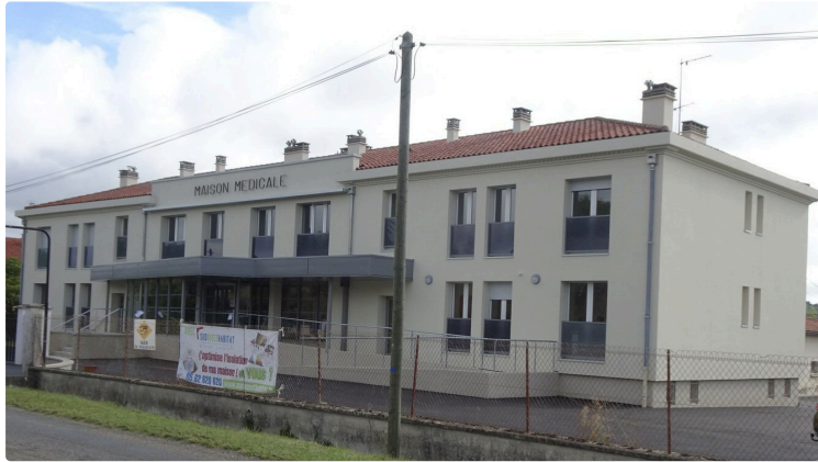
La nouvelle maison médicale en service
