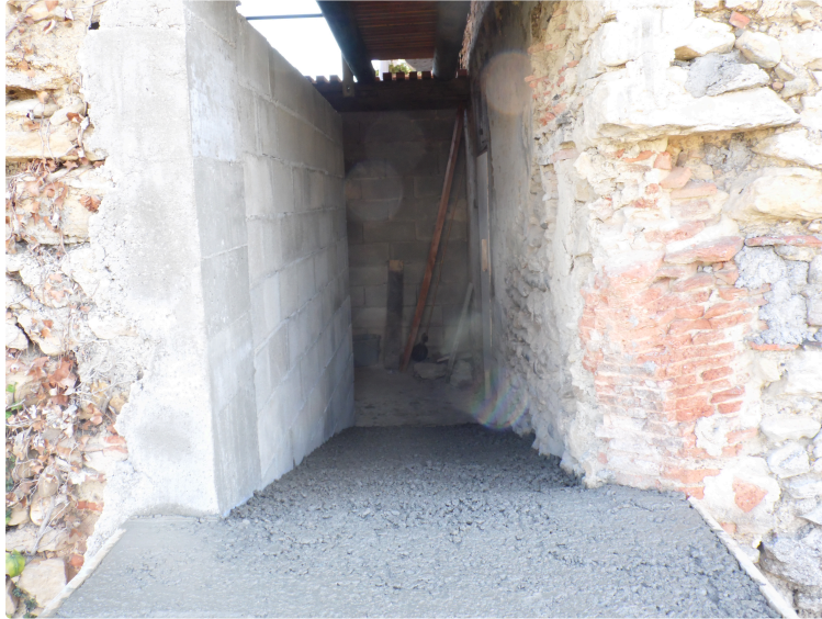
Les aménagements se terminent à la "Placita du Lartet"
