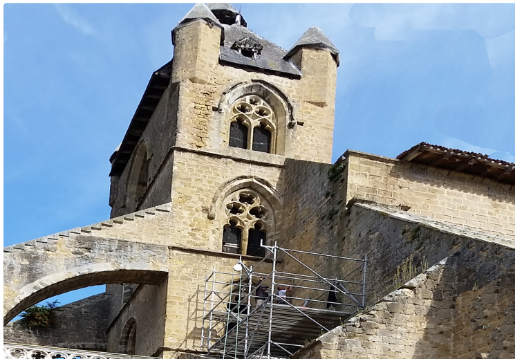
Eglise Sainte Marie, les travaux se poursuivent
