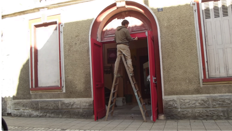
Porte d'entrée du "Central Cinéma" de Plaisance
