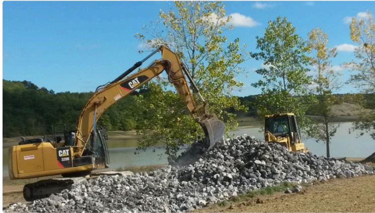
Saint-Pierre-d'Aubézies - Les travaux de la digue ont commencé
