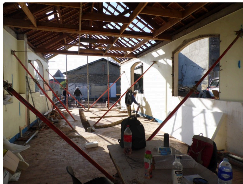
L'intérieur du bâtiment N0 3 coté rue basse
