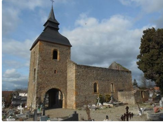
Restauration de la chapelle du cimetière
