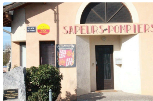
La caserne des Sapeurs-Pompiers
