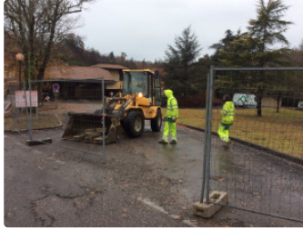
Le grand chantier a débuté
