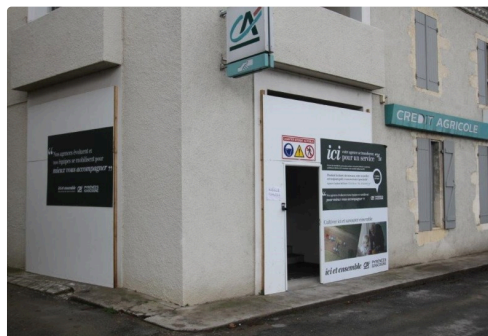
L'agence bancaire en travaux-Photos Marc Le Saux
