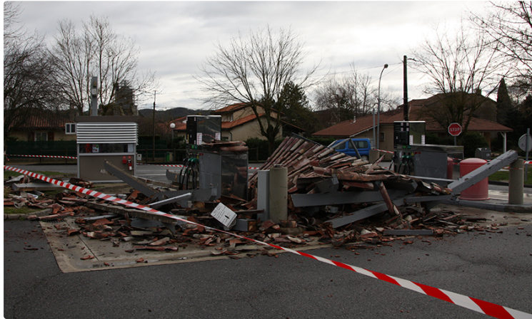
Faits divers la structure du point carburants s'effondre au Carrefour Market
