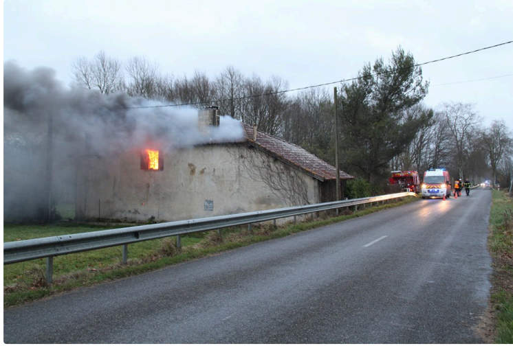
Une habitation détruite par un incendie.
