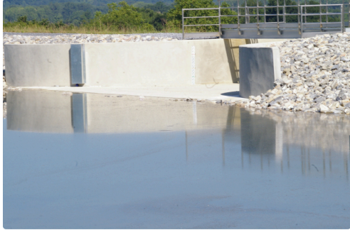
Le pont n'a plus de rambarde
