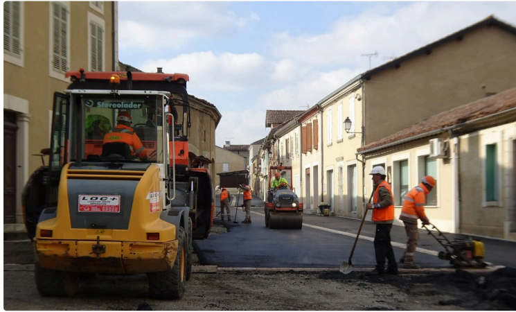
Fin du chantier de la rue du Marché
