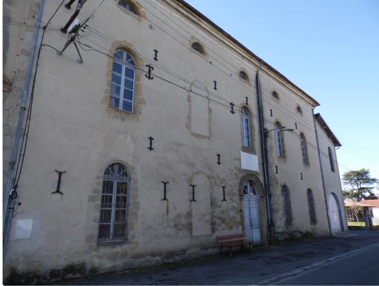
Conseil municipal en travaux
