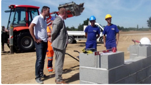
Pose de la première pierre du 22eme collège gersois
