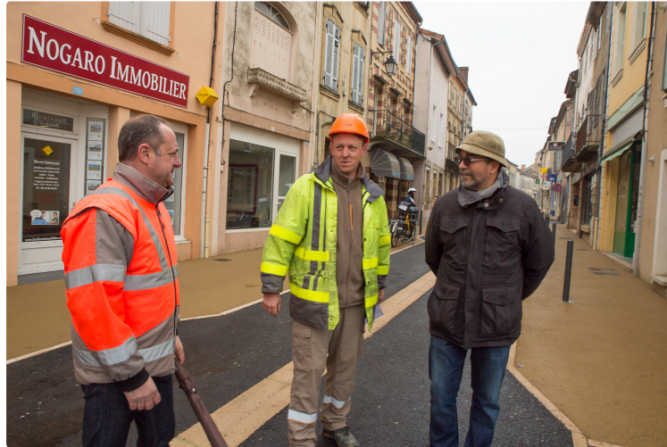
Fin du chantier rue de la République (ex-rue Nationale)
