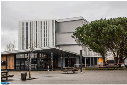
Le bâtiment du collège en cours de rénovation
