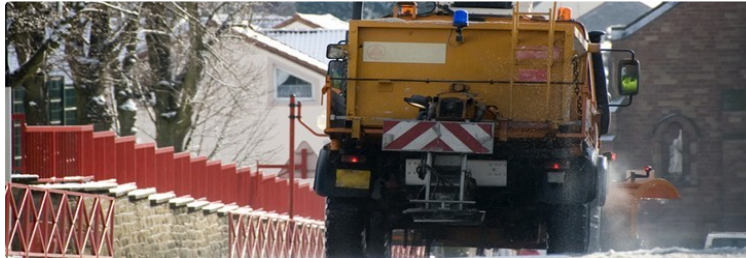
Travaux de réfection de chaussée sur la RN 21
