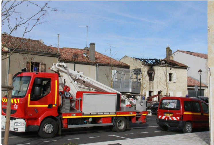
Une maison d'habitation détruite par un incendie
