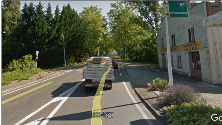
Réfection de la RN 21 à la sortie de Mirande
