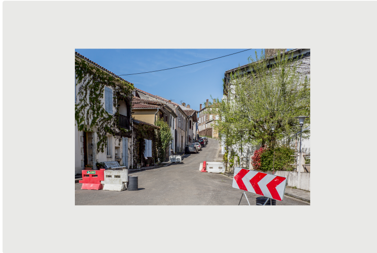
À Manciet la RD 931 est en réfection
