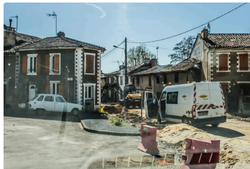
Vue des travaux en arrière-plan dans la ville basse
