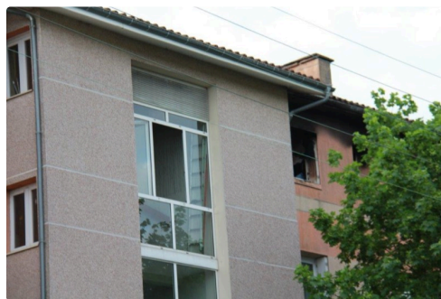
appartement depuis façade au Bat A1
