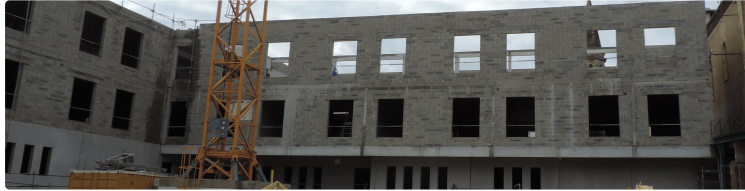
Condom les travaux en bonne voie
