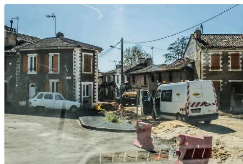
Les travaux en ville basse à Manciet
