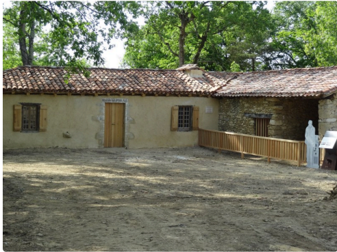
La bergerie restaurée
