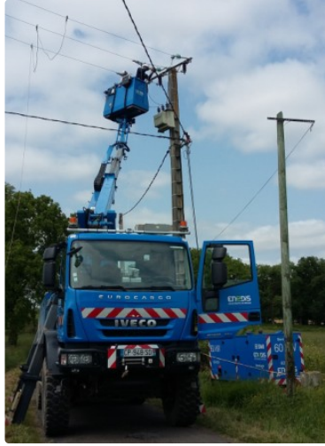
Protection des oiseaux et rénovation du réseau 20 000V Enedis compatible
