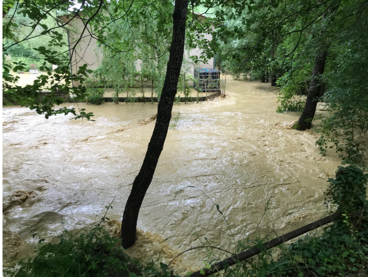
Inondations à Saint-Clar
