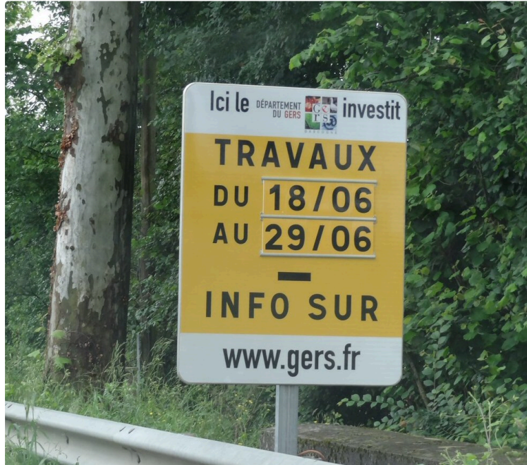
Travaux sur la départementale 929 et perturbation de la circulation
