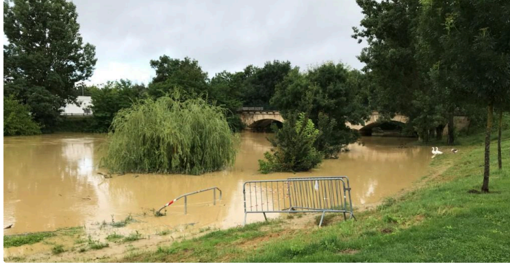
Travaux sur cours d'eau suite aux intempéries
