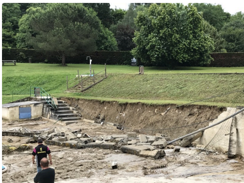
Après le passage de l'orage
