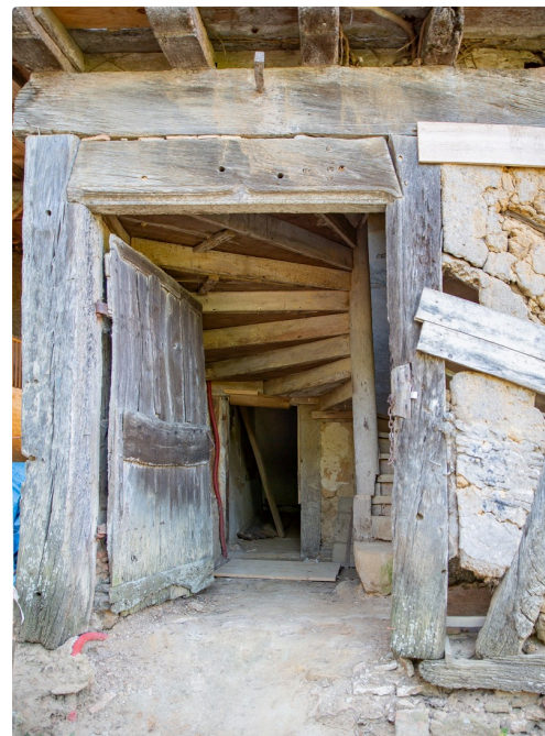
...avec la porte donnant sur l'escalier
