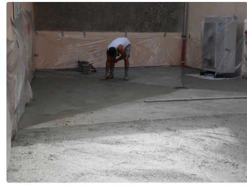
Mardi matin les finitions de la cour de la chaufferie avaient lieu
