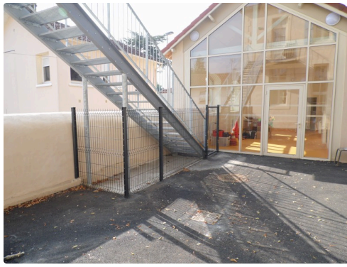
L' espace défendant l'accès à l'escalier de secours posé
