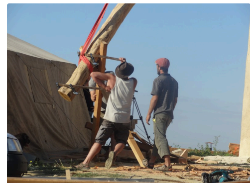
Mise en place de la queue du moulin
