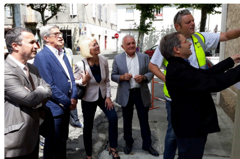
L'installation de la 1 ère armoire
