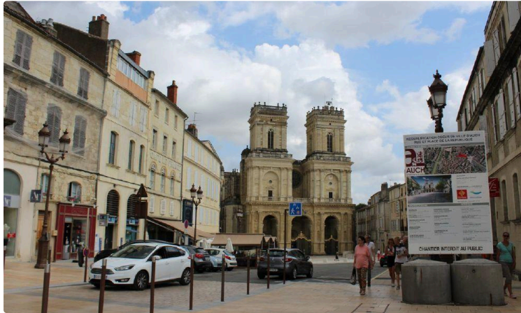
Début des travaux rue de la République
