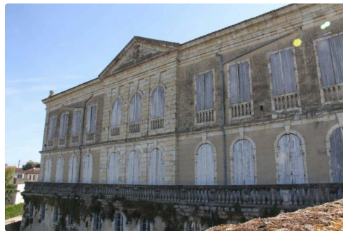
Face Ouest de l'hôtel Polignac, objet de la restauration.
