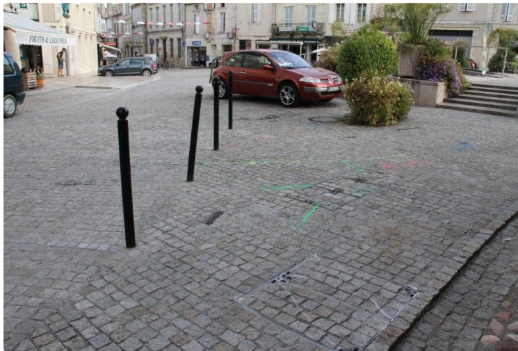
Travaux en centre-ville
